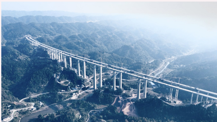
近日,由中建铁投承建的渝湘复线高速公路巴彭路二标全线贯通。渝湘复线高速公路横跨重庆市、湖南省两省,总长280.26公里,其中由中建铁投承建的巴彭路二标全长20.615公里。项目是国家高速公路网“71118”规划的重要路段,建成后对助力成渝地区双城经济圈建设具有重要意义。(张念)
