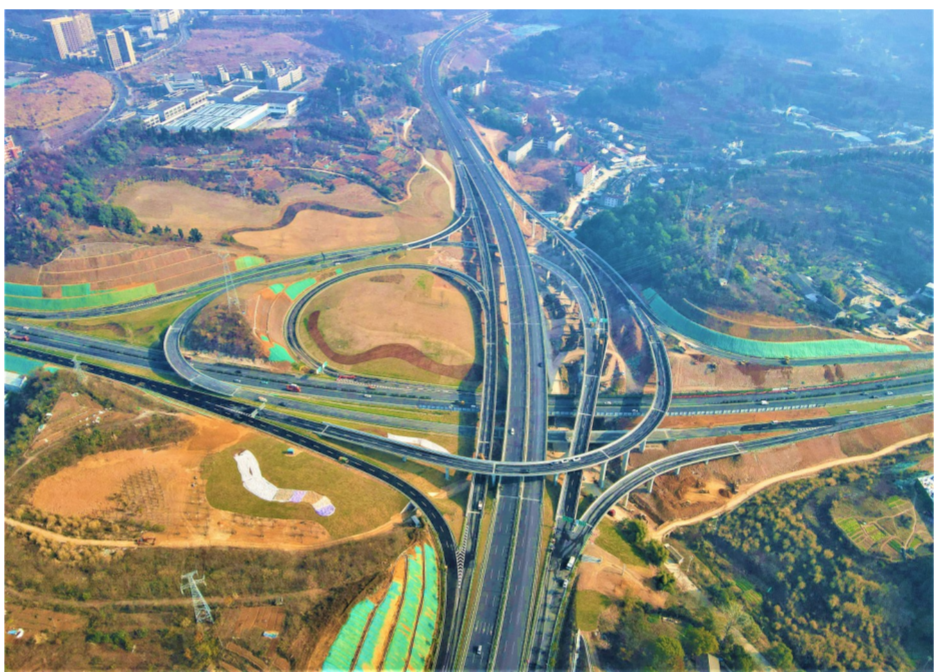
近日，中建三局承建的湖北省宜昌市三峡大道互通立交-港窑路节点互通工程正式通车。项目是宜昌市主城区当前工程体量最大、匝道层数最多、施工难度最高、地理环境最复杂的全互通立交，匝道及集散车道全长5.25公里，设计为“单环式梨形”全互通形式，是宜昌市快速路网“东进、北拓、中优”的重要转换枢纽。( 高宏建)
