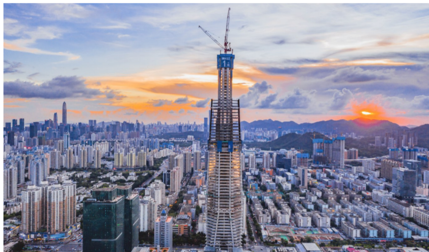
近日,中建三局承建的深圳在建第一高楼——城脉金融中心大厦项目核心筒封顶。项目高388米,采用新一代“空中造楼机”——新型轻量化支点顶模集成平台,全球唯一“单塔多笼循环运行施工电梯”等中建三局自主研发、行业领先的先进技术,建成后将成为深圳市金融改革创新及互联网金融集聚发展的重要载体。(覃楚涵)
