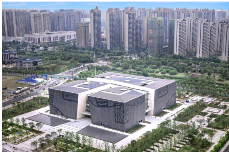
6月11日,中建八局承建的阜阳博物馆和阜阳图书馆顺利竣工,安徽省再添两座文化新地标。阜阳博物馆以方形几何体为主基调,仿佛裂石中崭露一方璞玉。建筑立面提取阜阳三亭碑刻文化意象,刻画出苍劲有力的文化符号,彰显“石开玉现,光宣诗韵”的文化气质。(张振宇)
